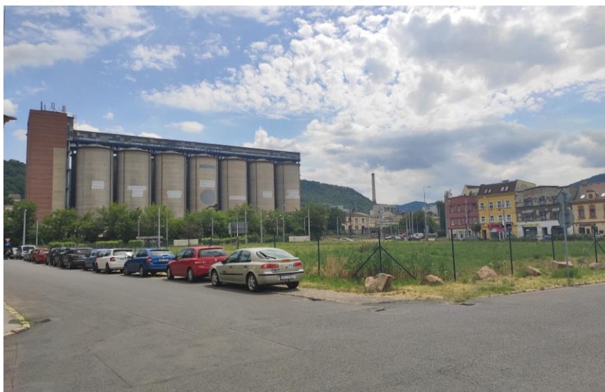
Obr. Části plochy přestavby P18-1, P18-4, P18-5, datum pořízení fotografie červen 2021
