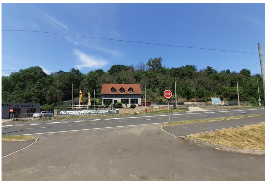
Obr. Zrušená zastavitelná plocha Z7-1, datum pořízení fotografie červen 2021
