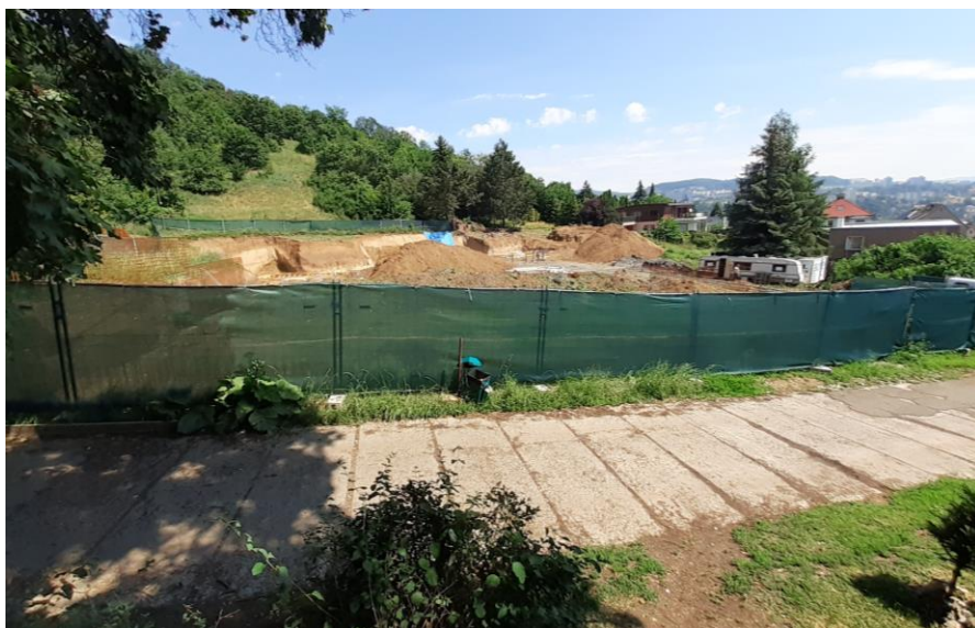
Obr. Zastavitelná plocha Z10-4(1), datum pořízení fotografie červen 2021
